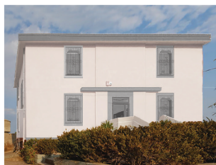
📍 Progetto di efficientamento energetico della biblioteca
